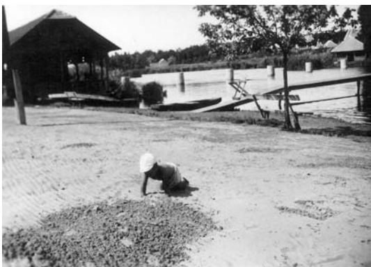
18. Háttérben az épülő fahíd pilléreiül szolgáló kútgyűrűk
