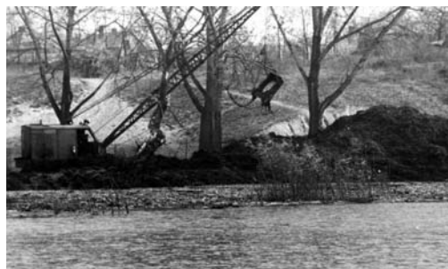
36. Úszóláp kotrás a Malom-tó keleti partján (1971)
