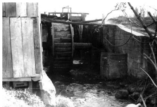
15. A malmot beton kifolyóval építették újjá, de csak egy kerékkel üzemelt
