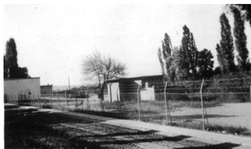
33. Bal oldalon a strandépület, középen a WC épülete, melyet néhány év után lebontottak (az új WC-t a főépület végéhez építették hozzá). Előtérben a strand drótkerítése
