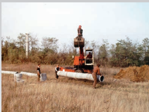
44. Vízvezeték építés Veresegyházon
